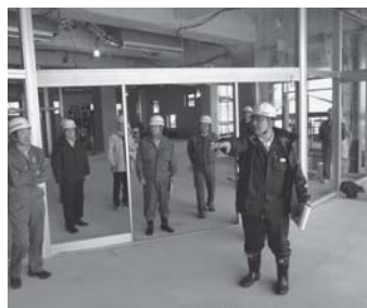
建設工事が進むフェリーターミナル 8月28日総務民教産建常任委員会時
