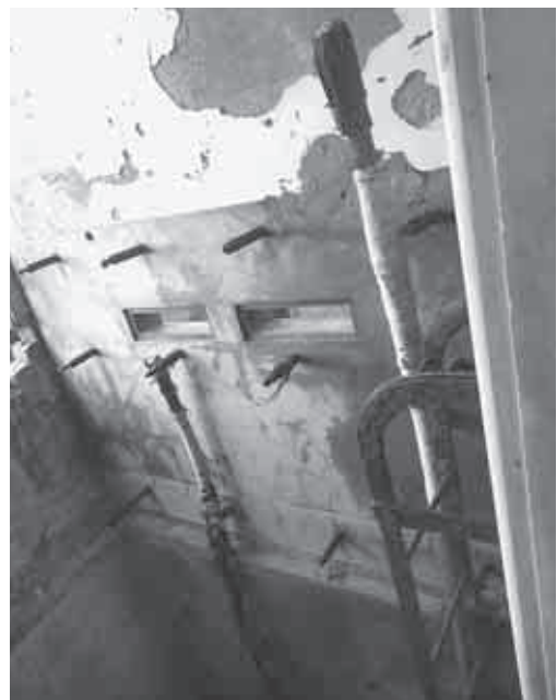
電線がのこる竪坑（ピット）内▶
