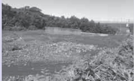
砂防ダム内及び河床への土石堆積
