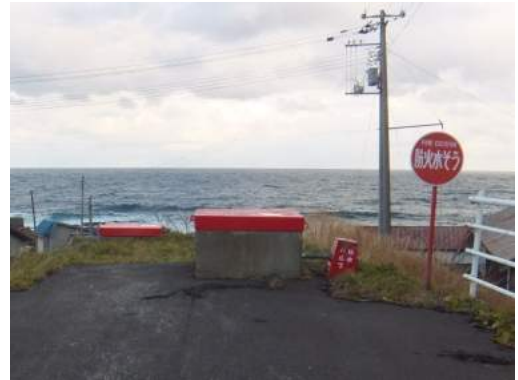
既設の防火水槽
