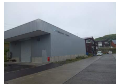
昆布集出荷施設
