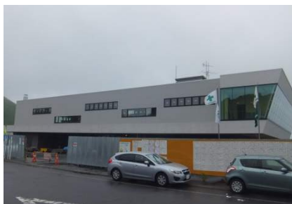
整備中のフェリーターミナル
